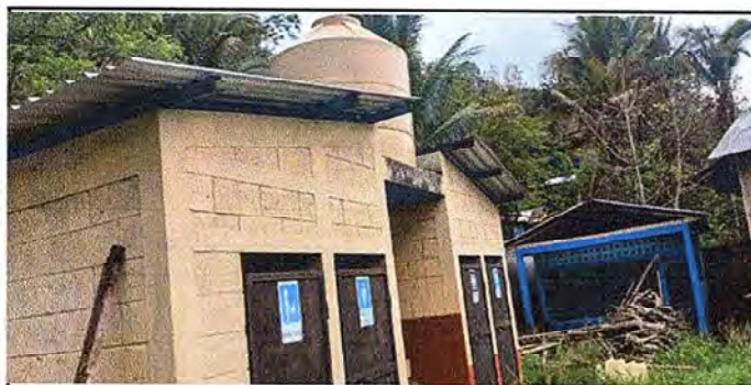
Foto 3: Colocacion de deposita de agua para los baños del Centro Educativo
