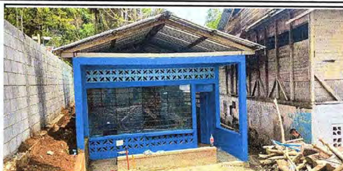
Foto 2: El area de la cocina terminado de pintar
