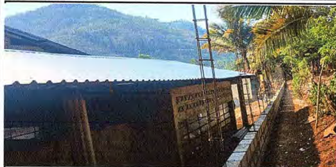
Foto 1: El techo de la cocina concluido.
