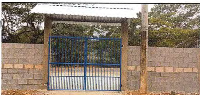
Foto 5: Porton y el techo terminado
