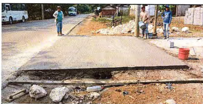
Foto 4: Colocando de tubos y luego la torta de concreto para drenar el agua en la entrada al Establecimiento Educativo terminado.
